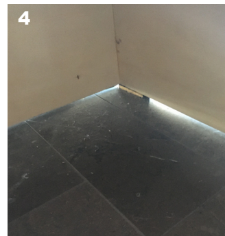
Væggen er ikke hermetisk lukket forneden, der kan komme træk / The wall is not hermetically sealed at the bottom, which can cause drafts.
