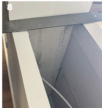
De 2 vægge skal være i vatter / The 2 wall must be in level.
