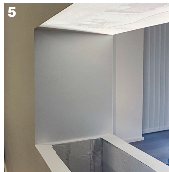
Pejsevæg lukket i top og sider / The fireplace wall closed at the top and sides.
